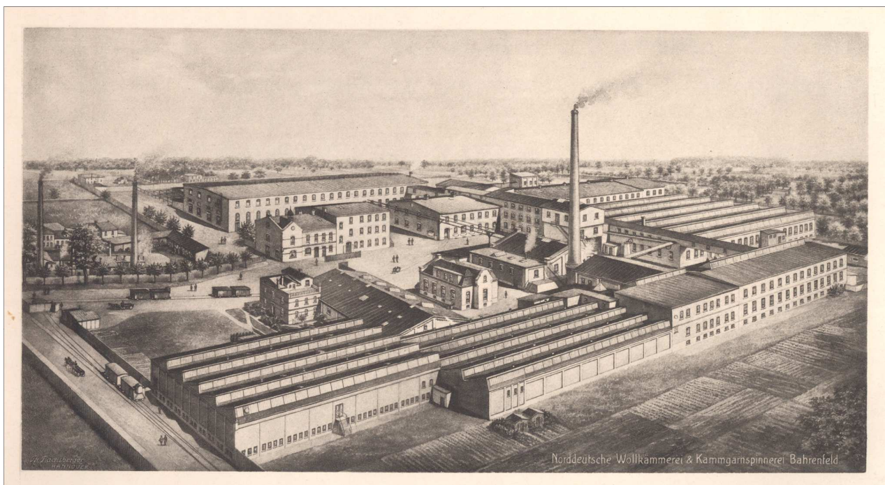
Blick auf die Sternwoll-Spinnerei in den 1920er Jahre vom Friesenweg aus. Erst 1925 wurde das Verwaltungsgebäude zur Griegstraße-Seite erbaut. Heute steht noch die rechte Produktionshalle.
